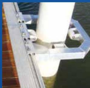
Système de guide-pieu avec galets en polyamide sur axe inox.
