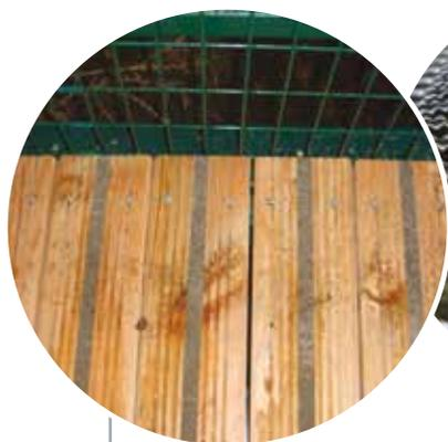
Platelage en bois avec bande antidérapante. Fixation par vis ou rivet.
